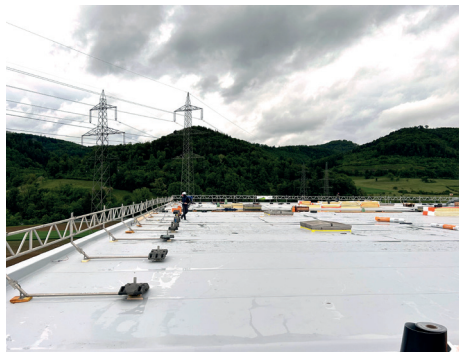
Temporäre Absturzsicherung während Bauphase
